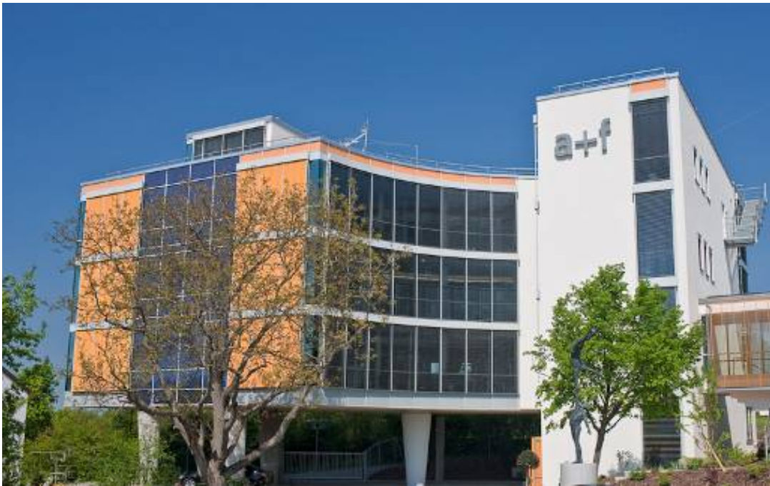
Nach neunmonatiger Bauzeit fertiggestelltes Kompetenzzentrum in der Würzburger Faulenbergstraße 4.
